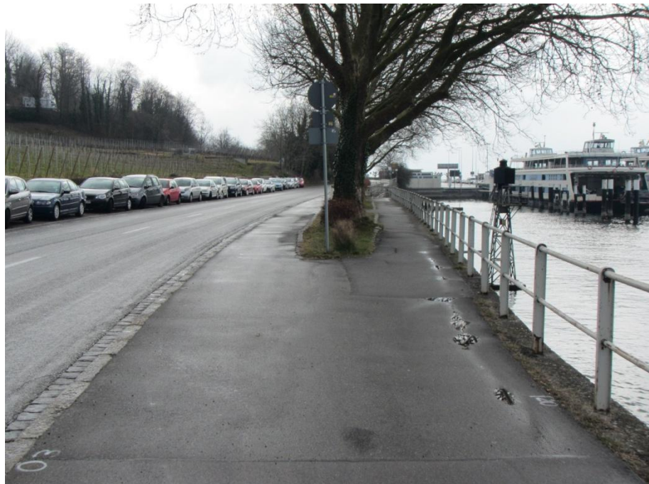
Abb. 7-22: Landesstraße 201 in Meersburg (Ortseinfahrt)
