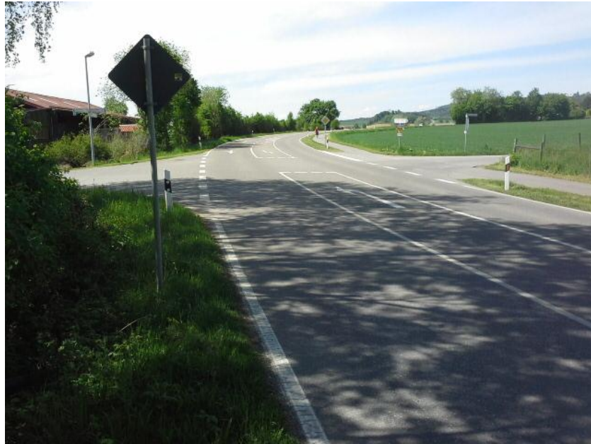
Abb. 7-9: Querung der K 7771 im Bereich Reutemühle
