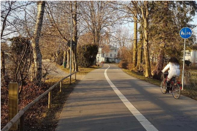
Abb. 29: Zählstelle Lotzbeckweg Lindau (Foto)
