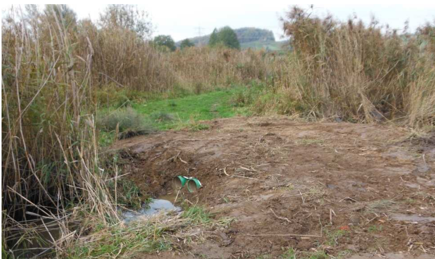
Abb. 24: Mit Kies, Textilvlies und Oberboden eingebaute Plastikrohre, um Vernässung abzuführen und Heckrindern ein sicheres Überqueren zu ermöglichen. Foto: J. Seif, 21.10.2015.
