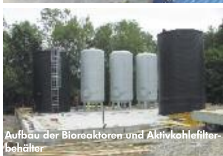
Überblick Baustelle Sickerwasseranlage
