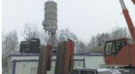
Demontage der alten Sickerwasseranlage / Abbau des Ozonbehälters
