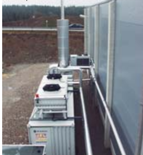
Gasmotor der aus Methangas Strom produziert
