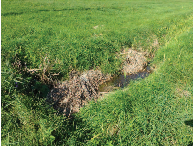
Abb. 5: Seitengraben zum Lipbach mit Ablagerungen an organischem Material
