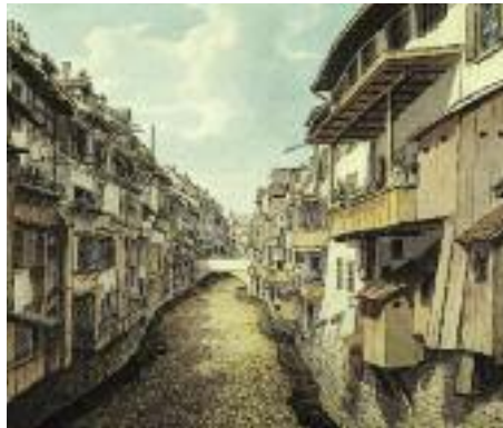
Hölzerner Abtrittkerker über einem Stadtbach in Basel, der als Abwasserkanal genutzt wurde
