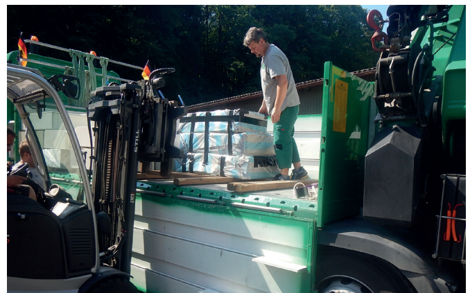
Fachgerechter Ausbau und Transport nach TRGS durch Spezialfirma
