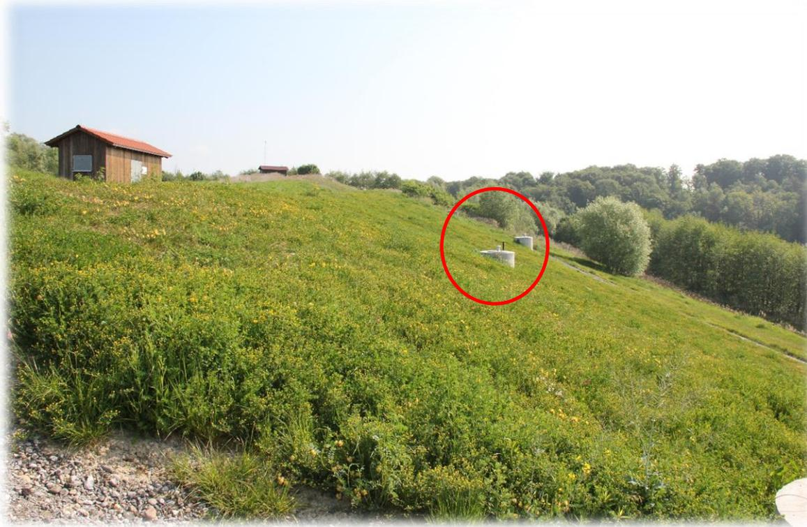
In den Brunnen wird kein Wasser gesammelt, sondern das Gas, das durch den faulenden Müll entsteht
