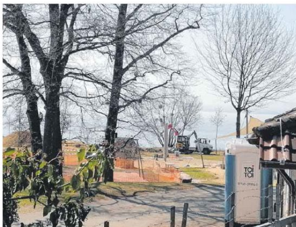
Die Bauarbeiten zur Versetzung der beiden Beachvolleyballplätze im Häfler Strandbad haben begonnen.
