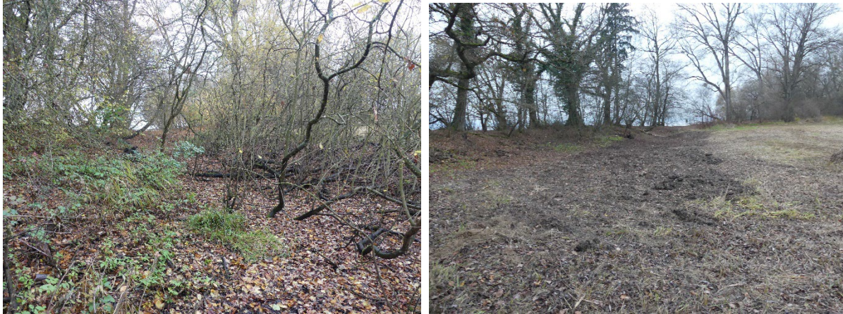
Abb. 7: Entbuschung einer Geländesenke vor dem Seehag im FFH-Teilgebiet „Seewiesen-Baggerloch“; Fotos: D. Doer: (a) Gehölzjungwuchs vor der Entbuschung, 08.11.2021; (b) Situation nach Entbuschung und Stockfräse-Einsatz, 24.11.2021.
