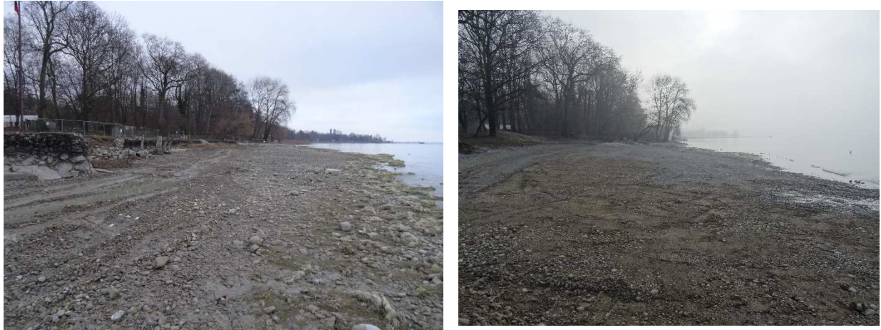
Abb. 9: Renaturierung des Bodenseeufers am Zeltlager Seemoos (Friedrichshafen), Fotos: D. Doer: (a) Situation zu Beginn der Renaturierungsarbeiten mit massiven Uferverbauungen im Hintergrund, 10.12.2015; (b) Situation kurz vor Abschluss der Renaturierung, 10.03.2016.
