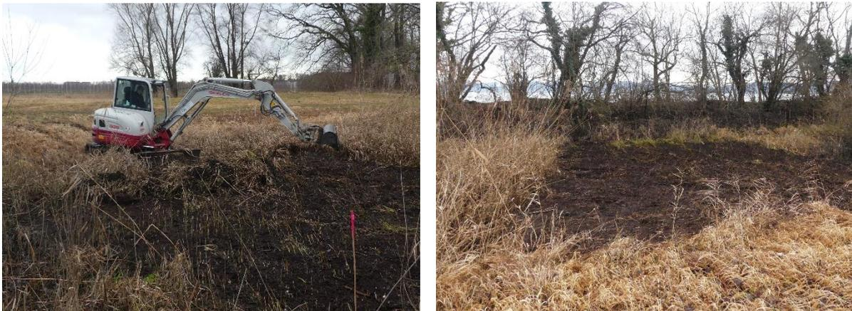
**Abb. 7:** (a) Freibaggern des westlichen Drittels der Schilfsenke am Tunauer Strand Ost als Artenschutzmaßnahme für den Kammolch; (b) Ergebnis der Freistellung mit dem Bagger mit Blickrichtung zum Bodensee. Fotos: D. Doer, 09.01.2025.
