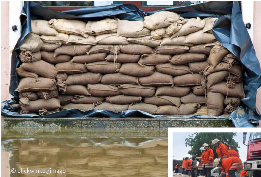
Schutzwälle aus Sandsäcken
