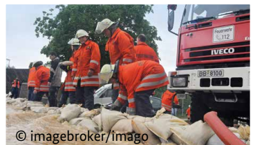
Schutzwälle aus Sandsäcken
